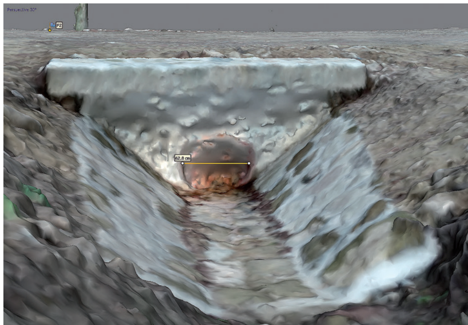
Ryc. 22. Pomiar światła wlotu przepustu rurowego (model 3D mesh) (źródło: program Agisoft PhotoScan)
