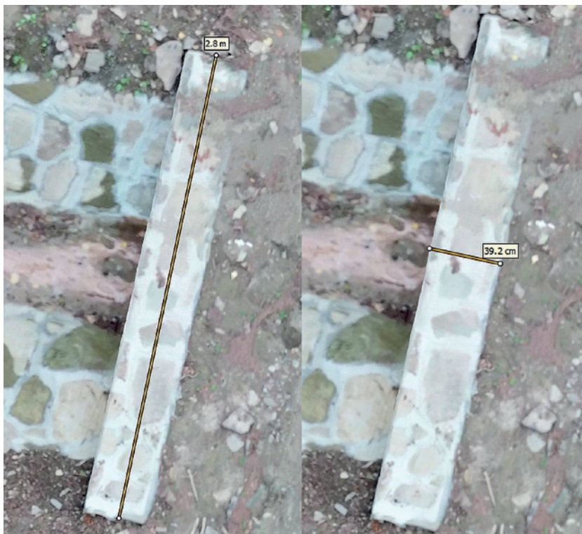
Ryc. 18. Wymiary ścianki wylotowej przepustu rurowego (długość i grubość) (źródło: program Agisoft PhotoScan)
