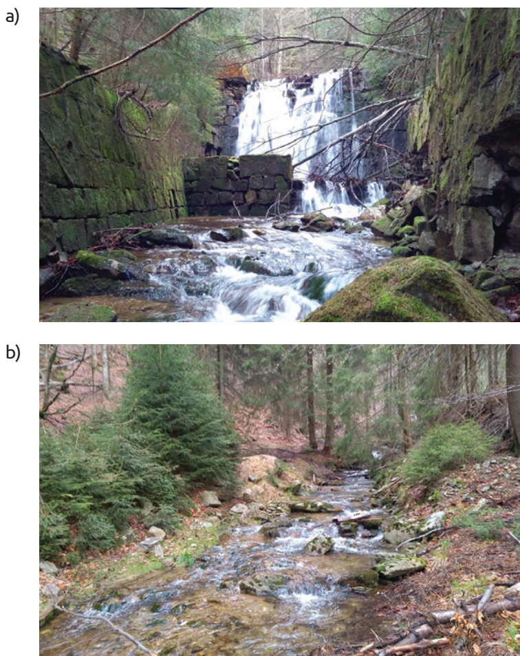
Ryc. 1. Widok na istniejącą zapórę przeciwrumowiskową (a) i dolina potoku powyżej załadowiska (b) (fot. P. Huskiewicz)
